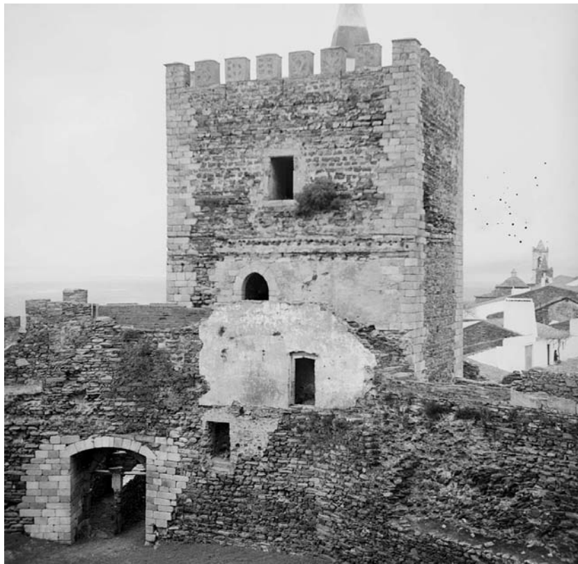
8. MONSARAZ, 1955. SIPA - SISTEMA DE INFORMAÇÃO PARA O PATRIMÓNIO ARQUITECTÓNICO FOTO.00162143. IMAGEM CEDIDA PELO IRHU/SIPA.
