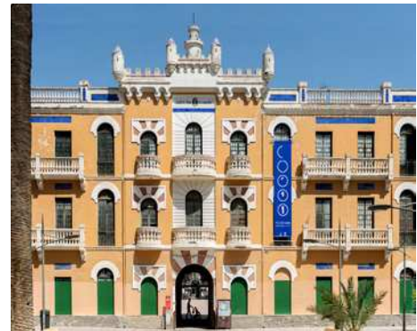
[FIG. 05]. ACCESO DESDE LA CALLE CARTAGENA AL PATIO DE ARMAS A TRAVÉS DEL PABELLÓN 1. FOTOGRAFÍA: JOSÉ LUIS CARRILLO, ARCHIVO PUERTAS DE CASTILLA.
