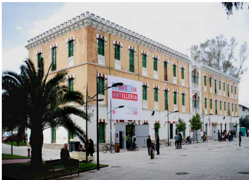
[FIG. 08]. PABELLÓN 2. FOTOGRAFÍA: COLECTIVO 2CON8, ARCHIVO PUERTAS DE CASTILLA.
