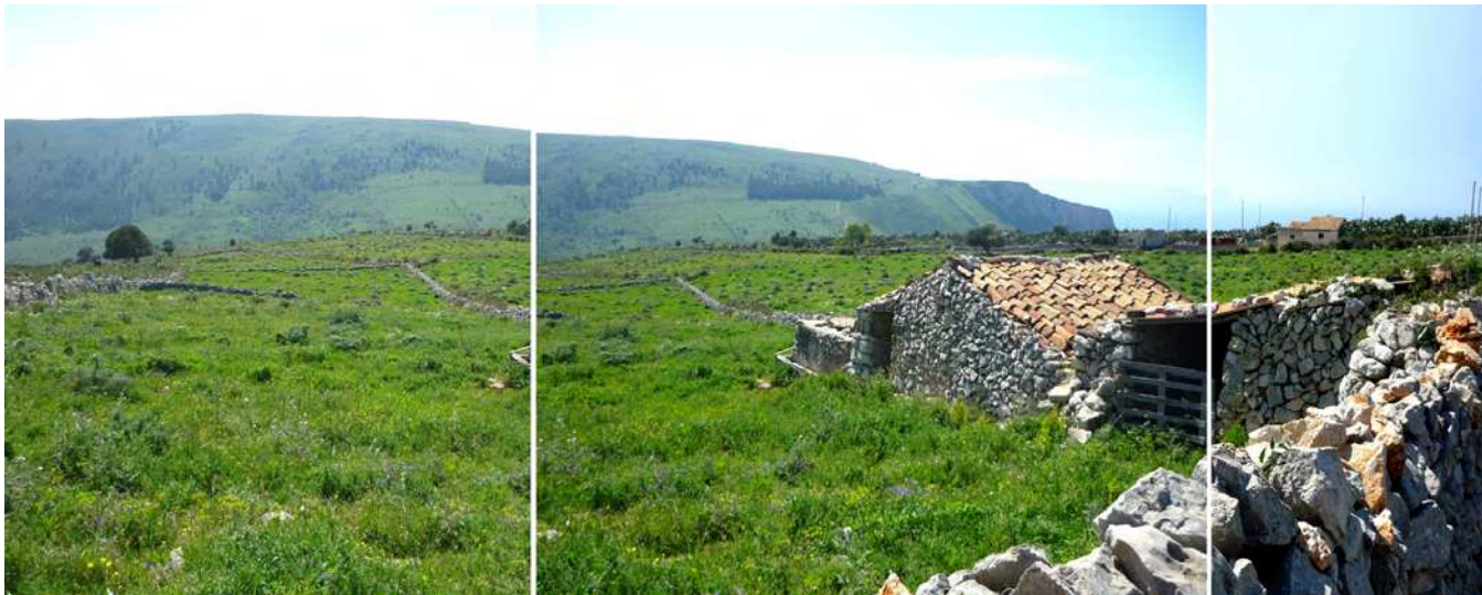
[FIG. 08]. CINISI (PALERMO), MURETTI A SECCO E DEPOSITO.
